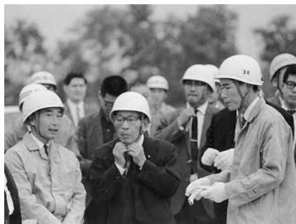
写真-2 昭和42年荒川左岸流域下水道工事で推進工法が採用され、当時の西村英一建設大臣（前列中央）が視察に訪れた際、当時の遠山啓工務部長（前列右）が説明役をつとめられた
