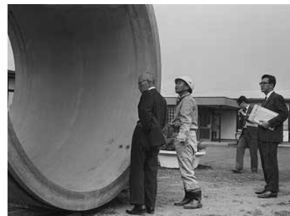
写真-3 当時の我が国初の呼び径2600の大口径推進管を大橋局長が西村大臣に説明
