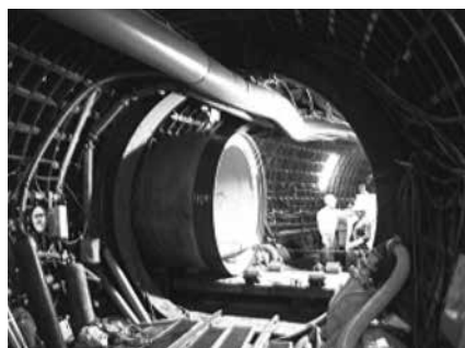
写真－1 推進管の横坑内への引き込み
