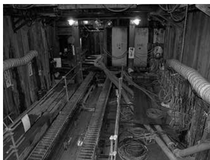
写真－2 トラバーサ（推進管横移動）
