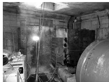
写真－3 支圧壁および元押装置設置状況
