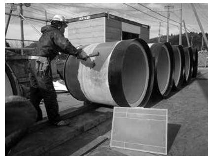
写真-7 コーティング材の塗布作業状況
