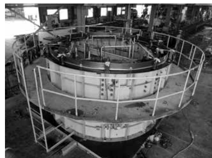
写真-3 推進管の製造(型枠組立)
