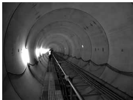
写真-10 推進管内状況 (呼び径4000)
