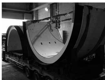
写真-4 推進管搬入状況
