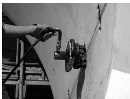
写真-7 コッタージョイント締結 (RC管)
