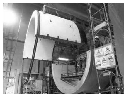
写真-6 上下部材組立
