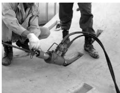
写真-8 PC鋼材の緊張 (PC管)
