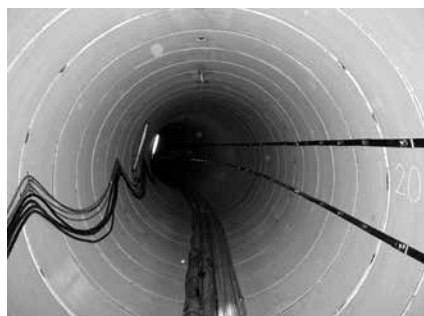
写真-1 SR推進管呼び径2400 (曲線半径25m)
