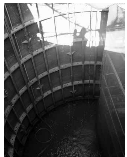
写真-3 潜水作業中
