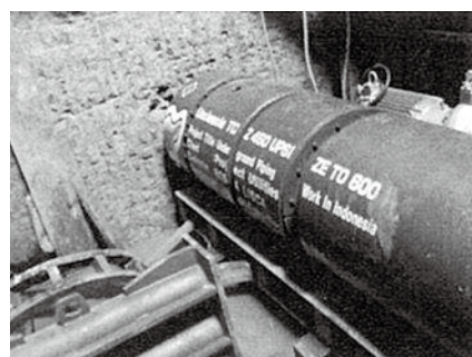
写真-3 坑口リングなしでの泥水式推進初期発達状況
