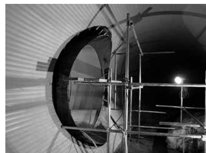
写真-3 刃口式推進機到達
