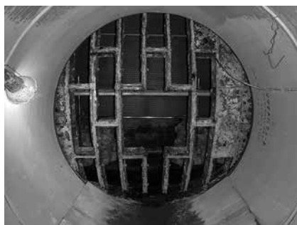
写真-2 既設構造物(セグメント)撤去状況 (接続管内径2,200mm 既設管内径4,000mm)
