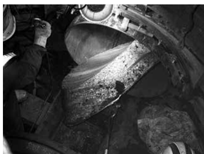
写真-5 直接到達状況 (トンネル内)
