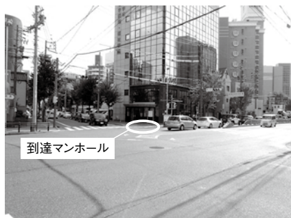
写真-1 到達マンホール付近
