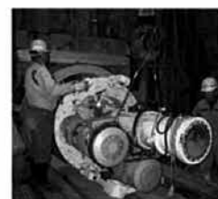
到達後、発進立坑側から本体回収
