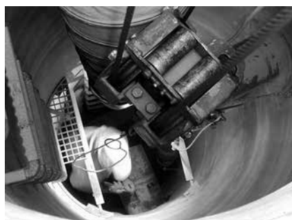
写真-1 小口径先導体の到達回収状況
