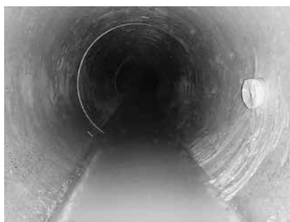
写真-2 既設管きょコア削孔状況
