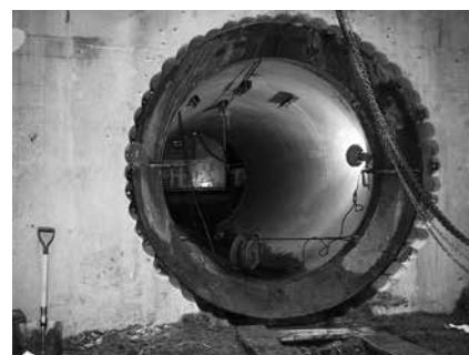
写真-3 刃口式推進工による既設構造物到達状況
