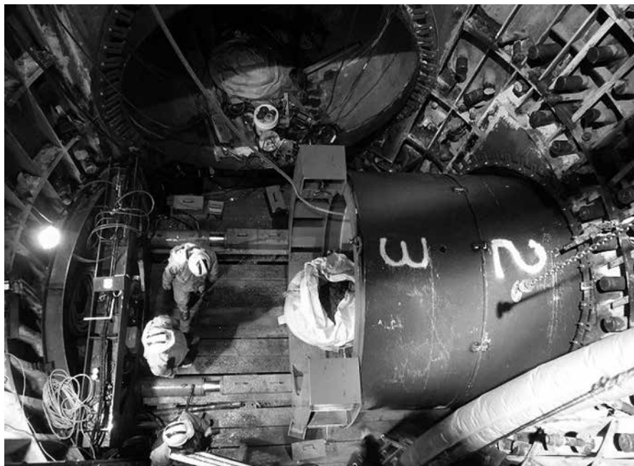
写真-1 接続推進工
