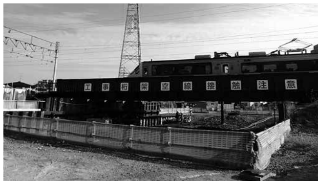
写真－2 工事桁
