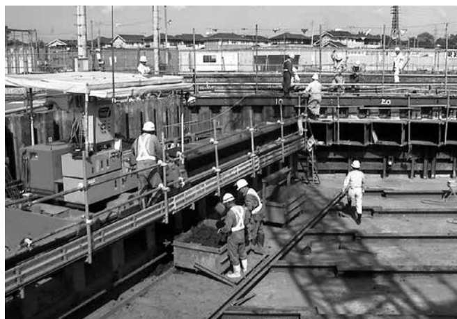
写真-1 URT推進機による推進の状況（トンネル形式）
