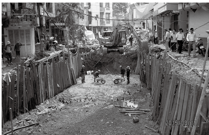
写真－1 市街地での開削工事
