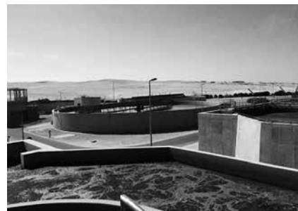
写真-3 現地調査 (Al Wathba2 下水処理場)
