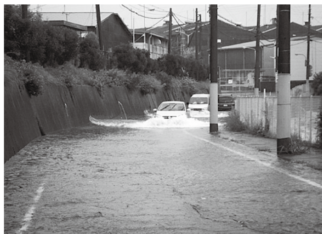
写真-2 浸水被害箇所②
