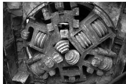
写真-3 鋼矢板Ⅲ型、切削貫通
