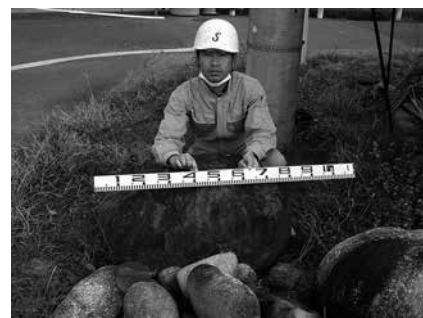
写真-2 発進立坑掘削時に出土した巨石
