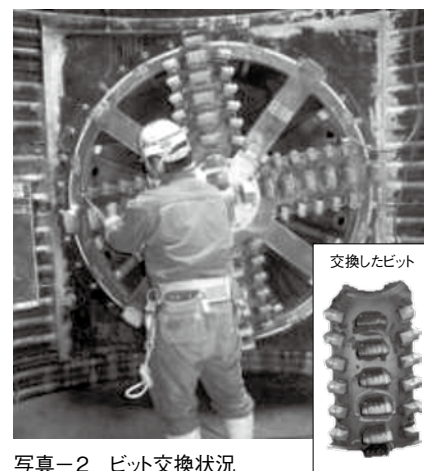
写真-2 ビット交換状況
