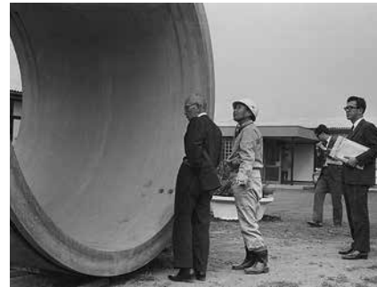
写真-3 当時の我が国初の呼び径2600の大口径推進管を大橋局長が西村大臣に説明
