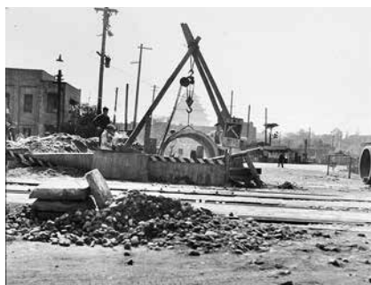
写真-2 昭和27年ごろの施工現場
