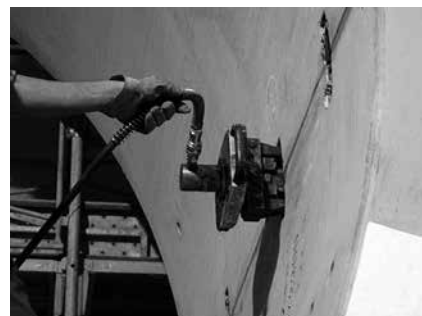
写真-5 コッター締結状況
