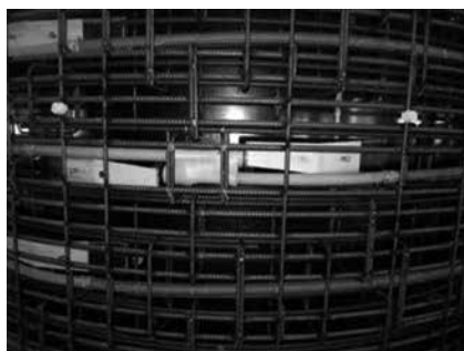
写真-1 シース管と定着体
