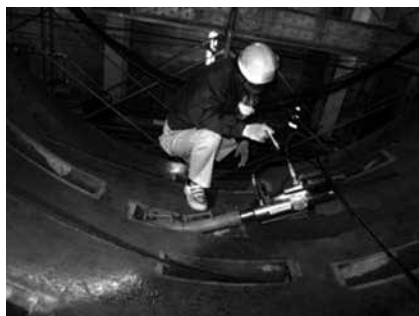
写真-4 PC鋼線緊張状況
