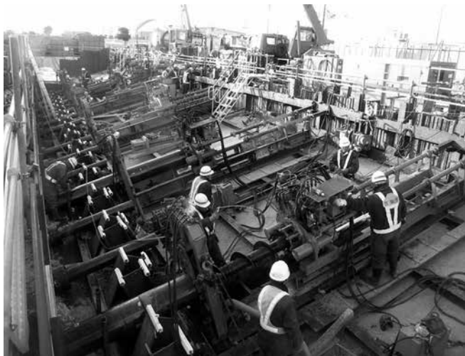
写真-1 施工状況
