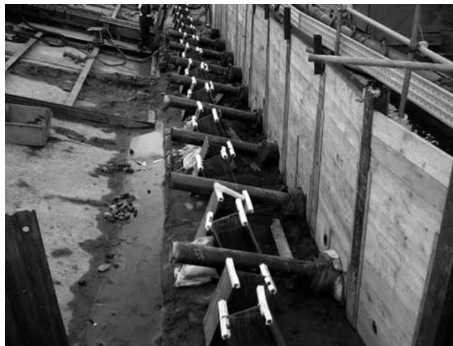
写真-2 推進完了
