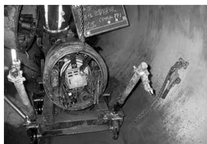
写真-2 先導体搬出状況
