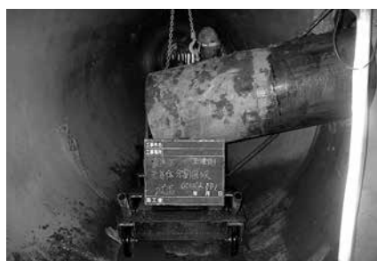
写真-1 シールド管きよ内到達状況
