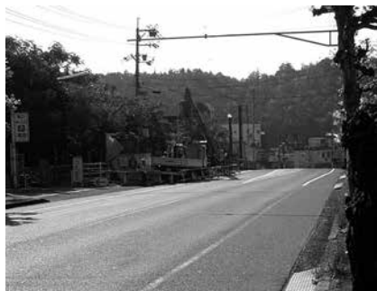
写真-1 施工現場付近
