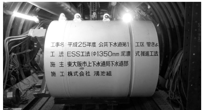
写真-1 掘進機シールド坑内掘付け準備状況
