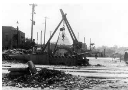
写真－1 昭和50年ごろの施工現場
