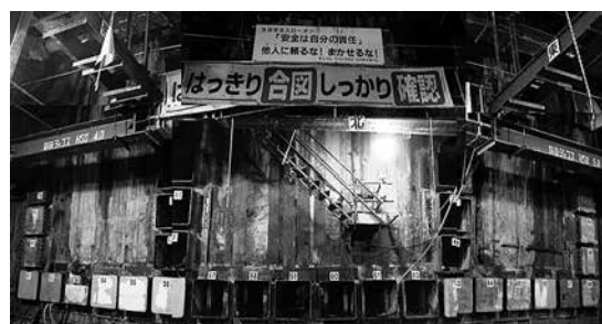
写真-4 推進完了後の状況
