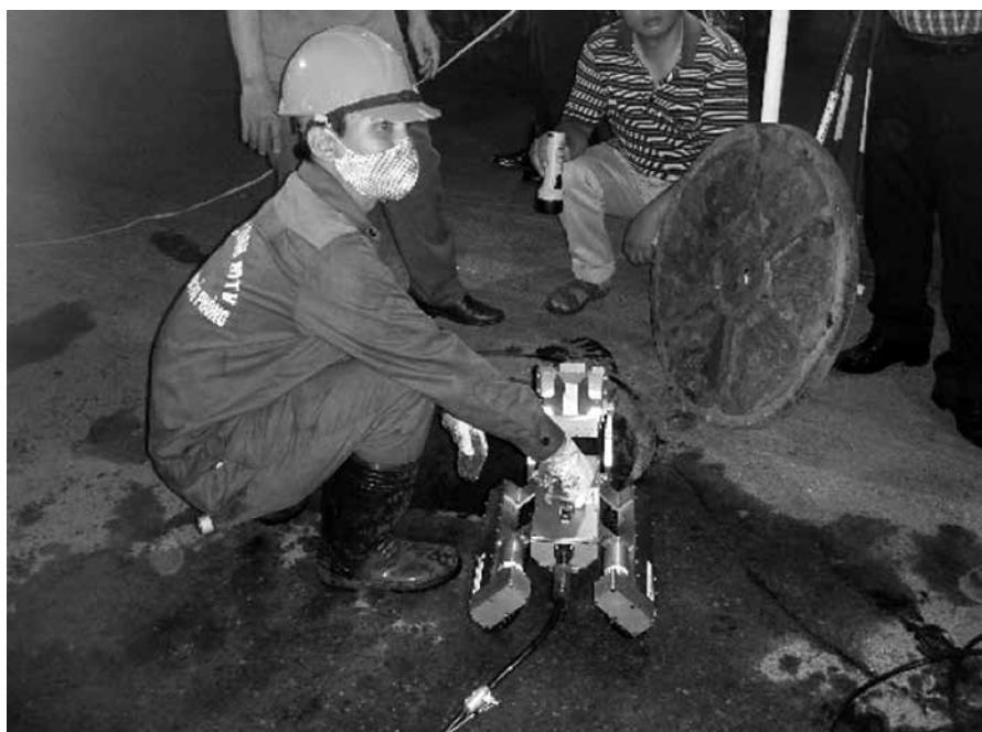
写真-2 会員企業の調査ロボットでの管きょ調査の様子
