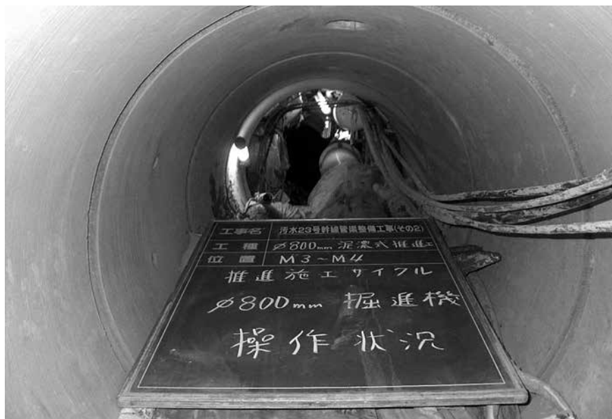
写真-4 推進工事現場作業状況 その2
