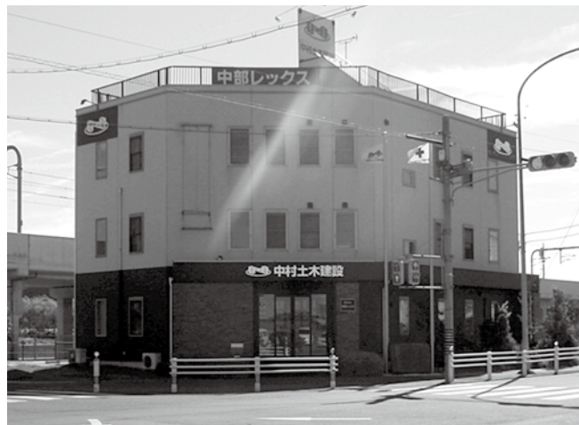
写真-2 現在の社屋(平成21年8月に新設)
