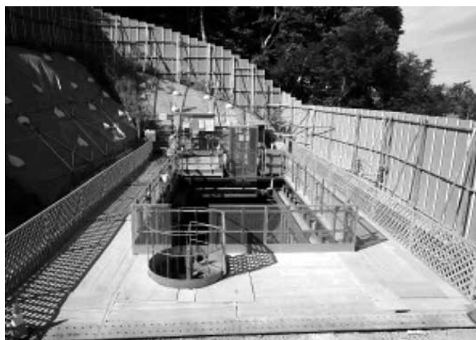
写真-2 工事用エレベータなどの設置で厳しい環境の整備
