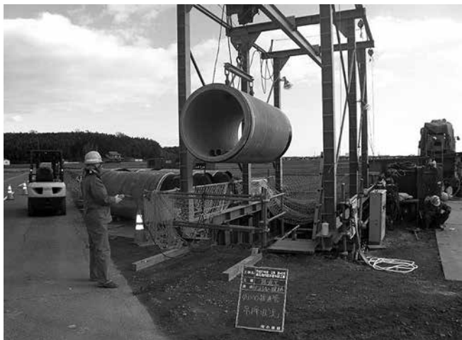
写真-2 施工状況①
