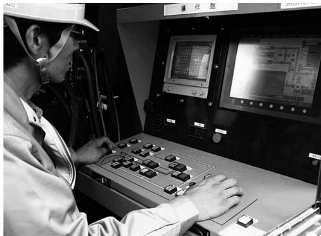
写真-3 施工状況②
