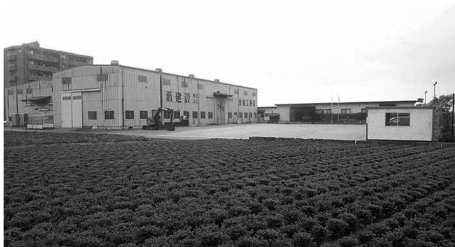
写真-1 社屋の外観
