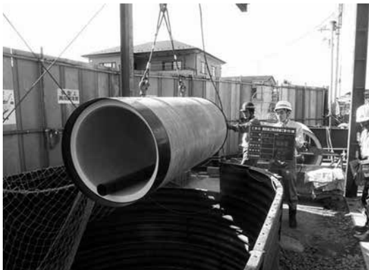
写真－1 初めて担当した推進工事現場（φ900mm泥濃式）
