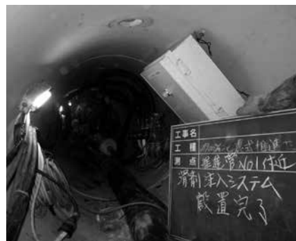
写真-1 滑材注入システム設置状況
