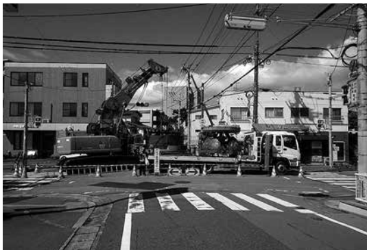
写真-1 発進立坑構築状況
