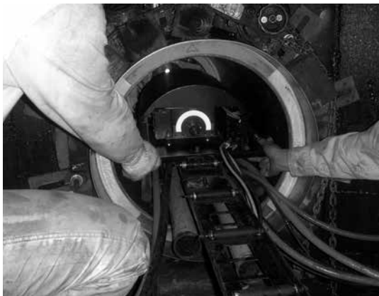
写真-1 JyAT工法（RMφ450mm）管内測量ユニット設置状況
