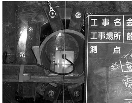
写真-2 JyAT工法（RMφ450mm）到達坑口 電磁波受信計測器設置状況
