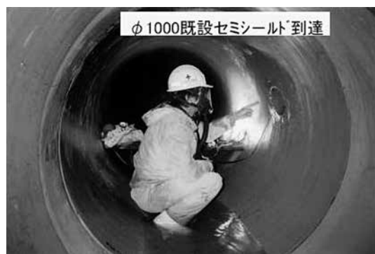
写真-4 φ1000mmセミシールド接続部
