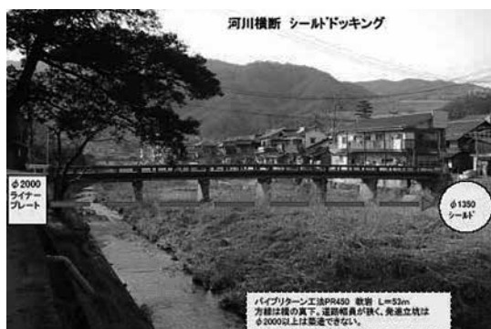
写真-3 河川横断シールド接続 L=53m
