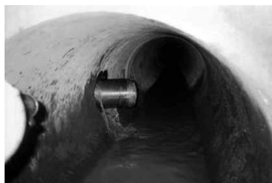
写真-5 河川横断φ800mmHP到達部
