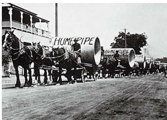
写真－3 ゴールドコーストへの馬によるヒューム管の運搬（1910年頃）
