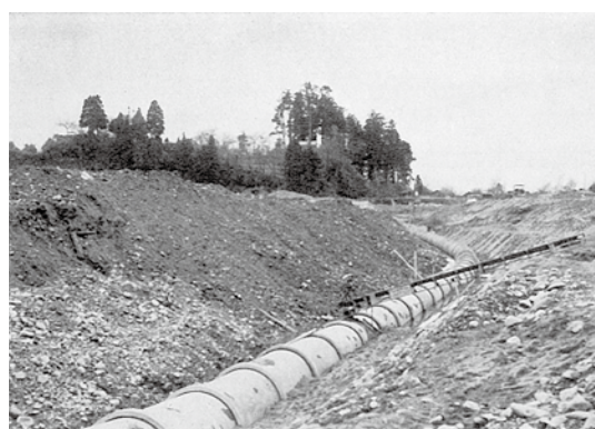
写真－5 農業用水の施工（昭和39年・秋田県内）
