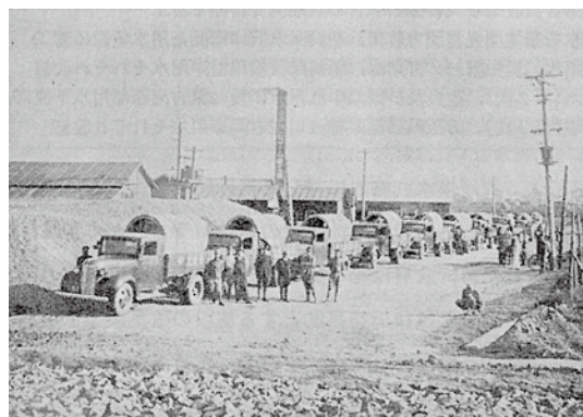
写真－4 戦前の管の運搬（昭和13年頃）
