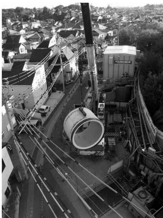
写真-1 発進基地全景
