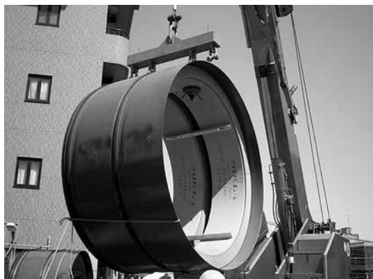
写真-1 MAX推進管の納入状況（2本連結）
