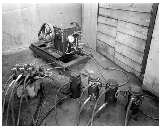
写真-3 油圧ポンプの動力化
