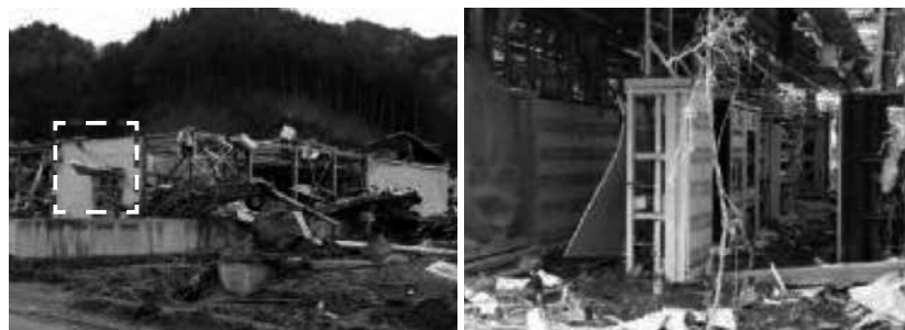
写真-2 通信ビルの損壊
