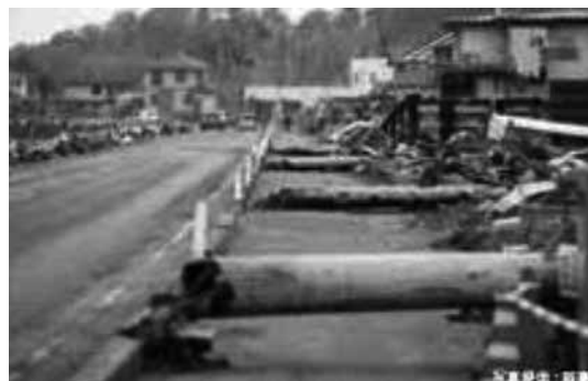
写真-1 津波による電柱折損
