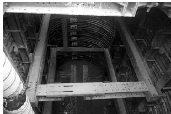
写真-4 \phi 1,350\text{mm} 泥濃式推進工法 発進立坑
