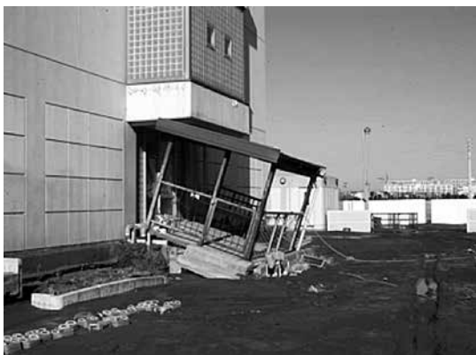
写真-3 小学校の被害
