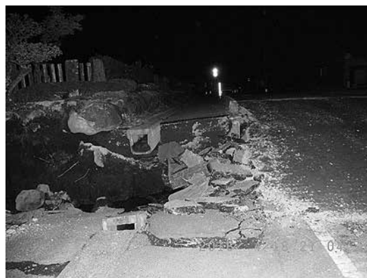
写真-2 4月18日現地入りしたときに撮影した陥没箇所
