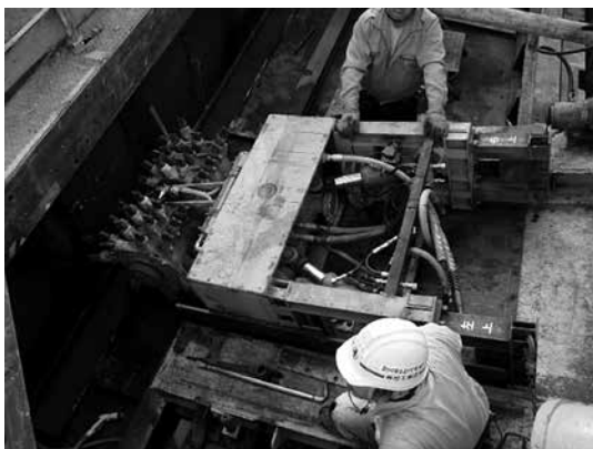
写真-1 まがる一ふ機 組立て (□1,240×680mm対応機)
