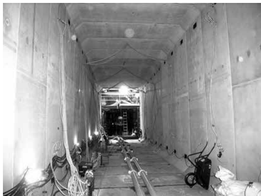
写真-1 施工状況①
