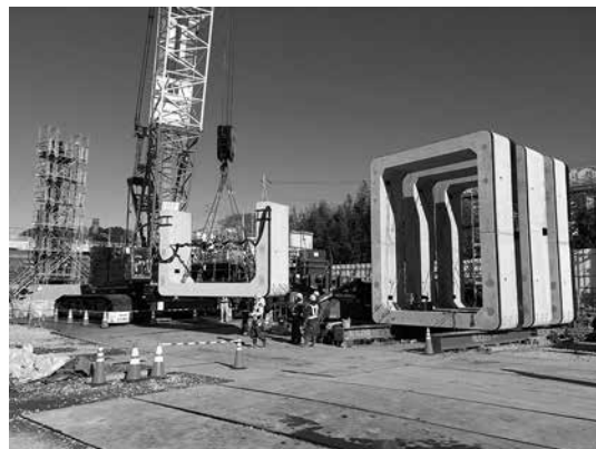
写真-2 施工状況②
