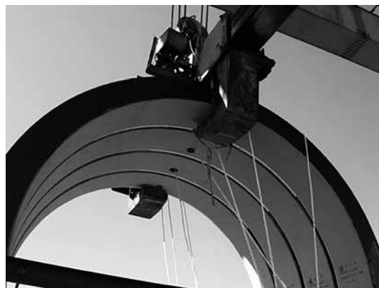
写真-2 1/4管の積込状況例
