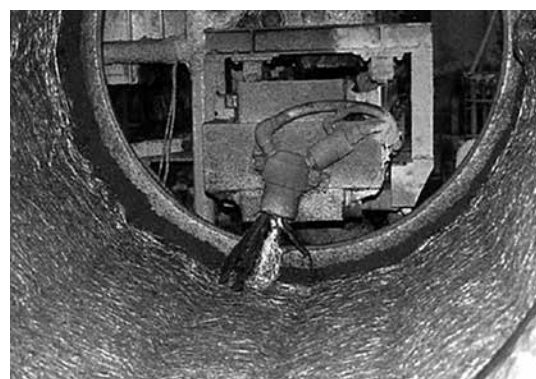
写真-1 ガラス繊維 ARG ファイバ投入
