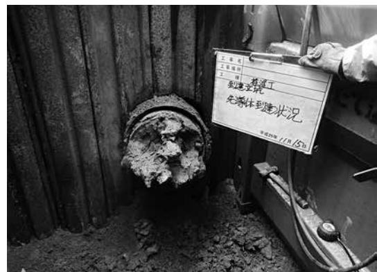
写真-2 簡易土留めへの到達状況
