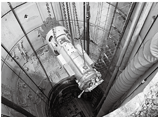
写真-1 試験施工の様子
